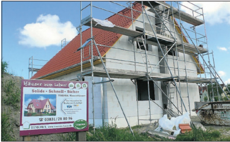
Aktuelle Timowa-Baustelle auf dem Gelände der ehemaligen Zuckerfabrik.
