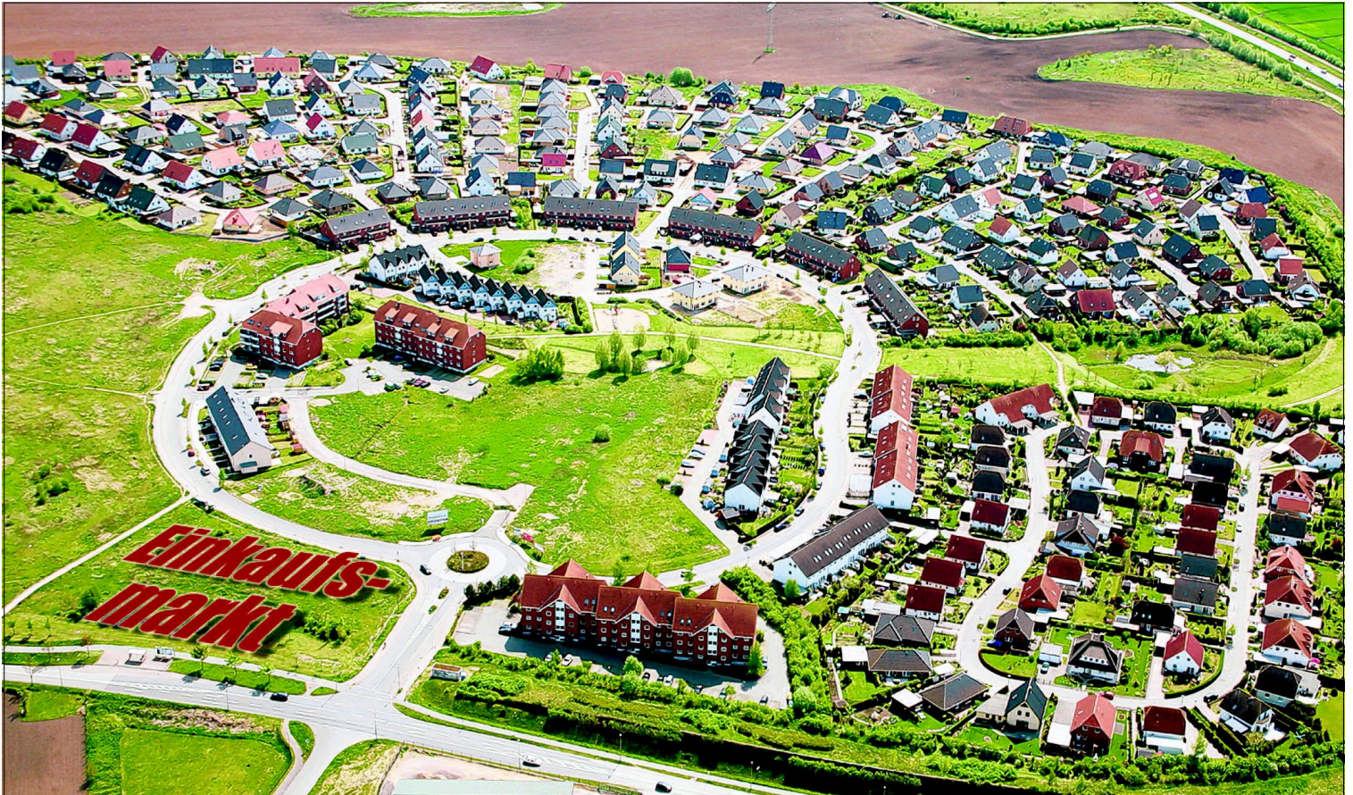
Im Wohngebiet Gartenstadt sollen noch in diesem Jahr ein Einkaufsmarkt an der Dammhüsener Chaussee errichtet und weitere Grundstücke (im Bild oben links) erschlossen werden. Foto: H.-J. Z.
